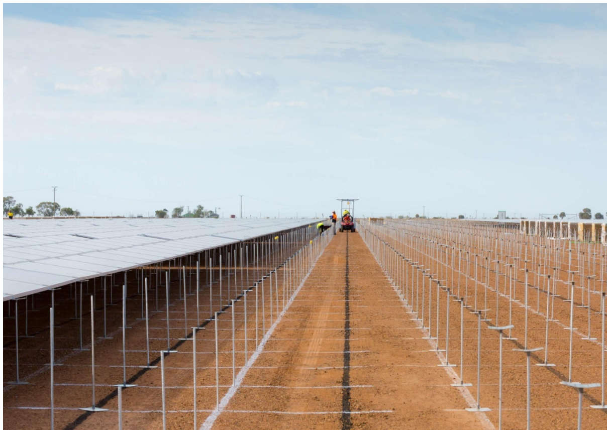
Zdj. 7. Zdjęcie z montażu konstrukcji wsporczej (system PEG, źródło: Belectric)
