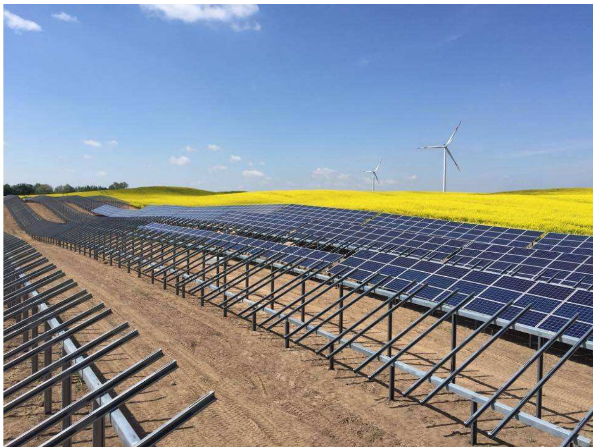
Zdj. 6. Zdjęcie z montażu konstrukcji wsporczej (źródło: www.wbijanie.pl )
